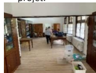
Locaux rénovés et aménagés par TA1AMI. (avec l'aide des Bricos du Cœur).
